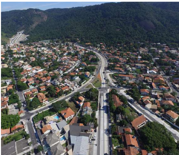
Foto aérea da construção da Transoceânica
