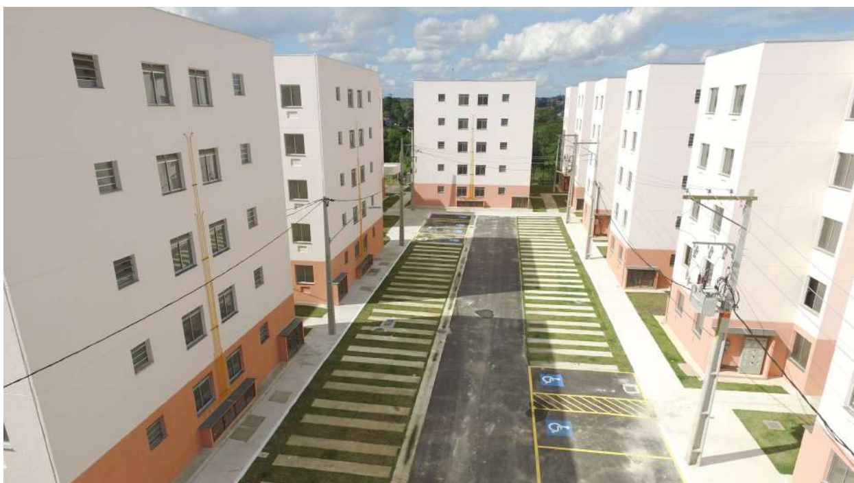
Novas unidades habitacionais construídas
